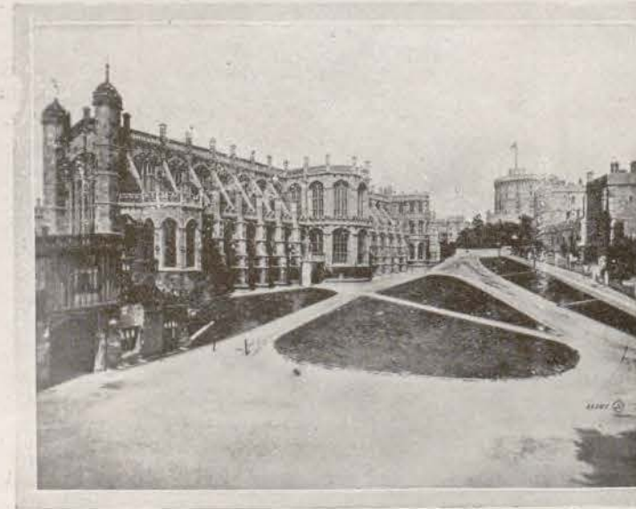
Exterior de la capilla de San Jorge y la Torre circular.
