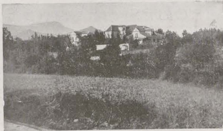
Exterior de los pabellones de Valdelasierra, rodeados de frondosa arboleda.
