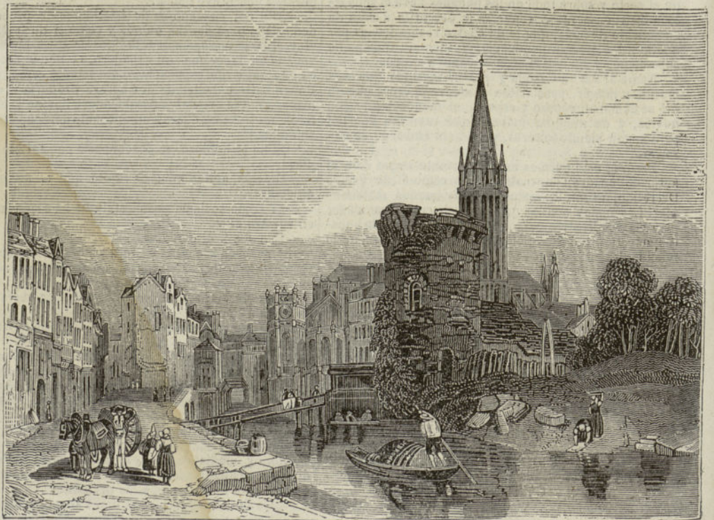
CAEN.—Lo primero que impresiona al viajero al recorrer á Caen, es la regularidad de las calles y la hermosa construcción de sus edificios. Tiene un puerto demasiado insignificante, solo propio para el cabotage.
