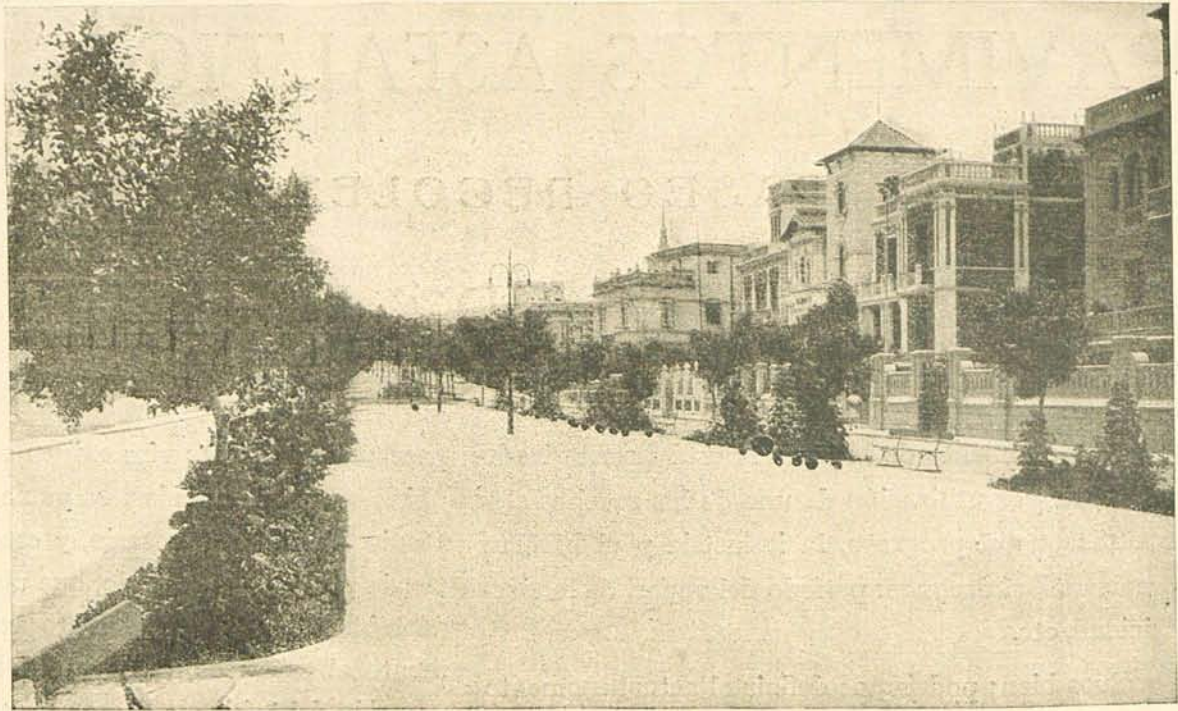
SANTA CRUZ DE TENERIFE (Canarias).—Rambla XI de Febrero, pavimentada con hormigón asfáltico
