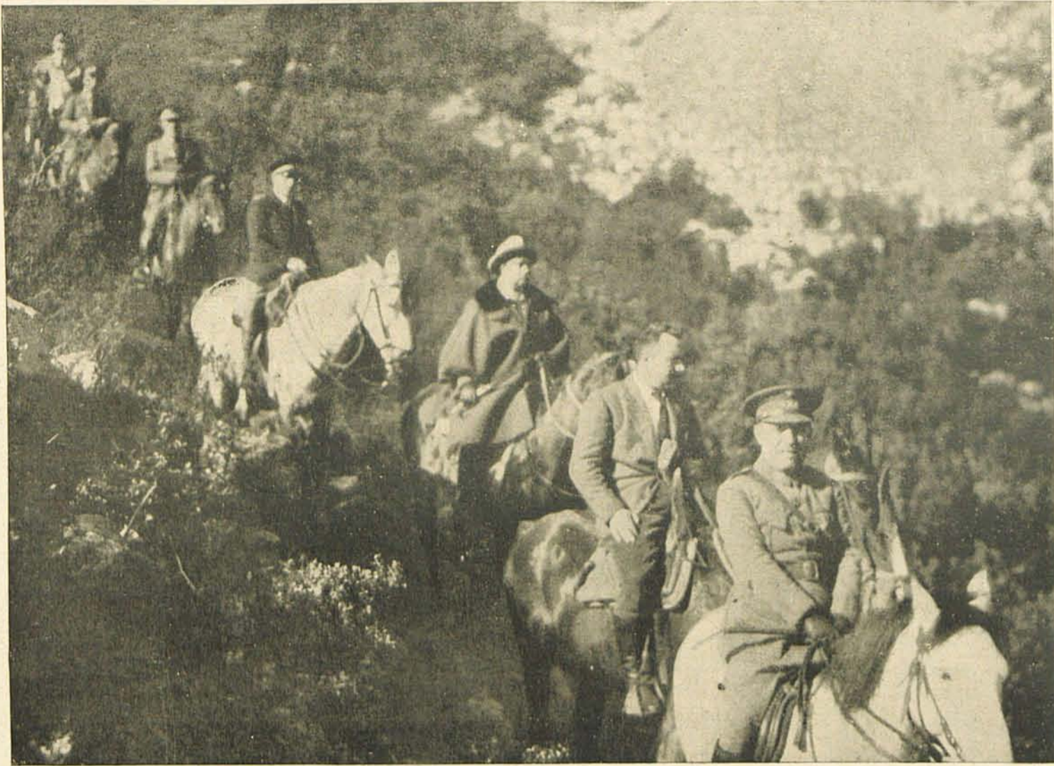
El Alto Comisario de Marruecos dirigiéndose a visitar las obras de construcción de la carretera de Tetuán a Melilla
