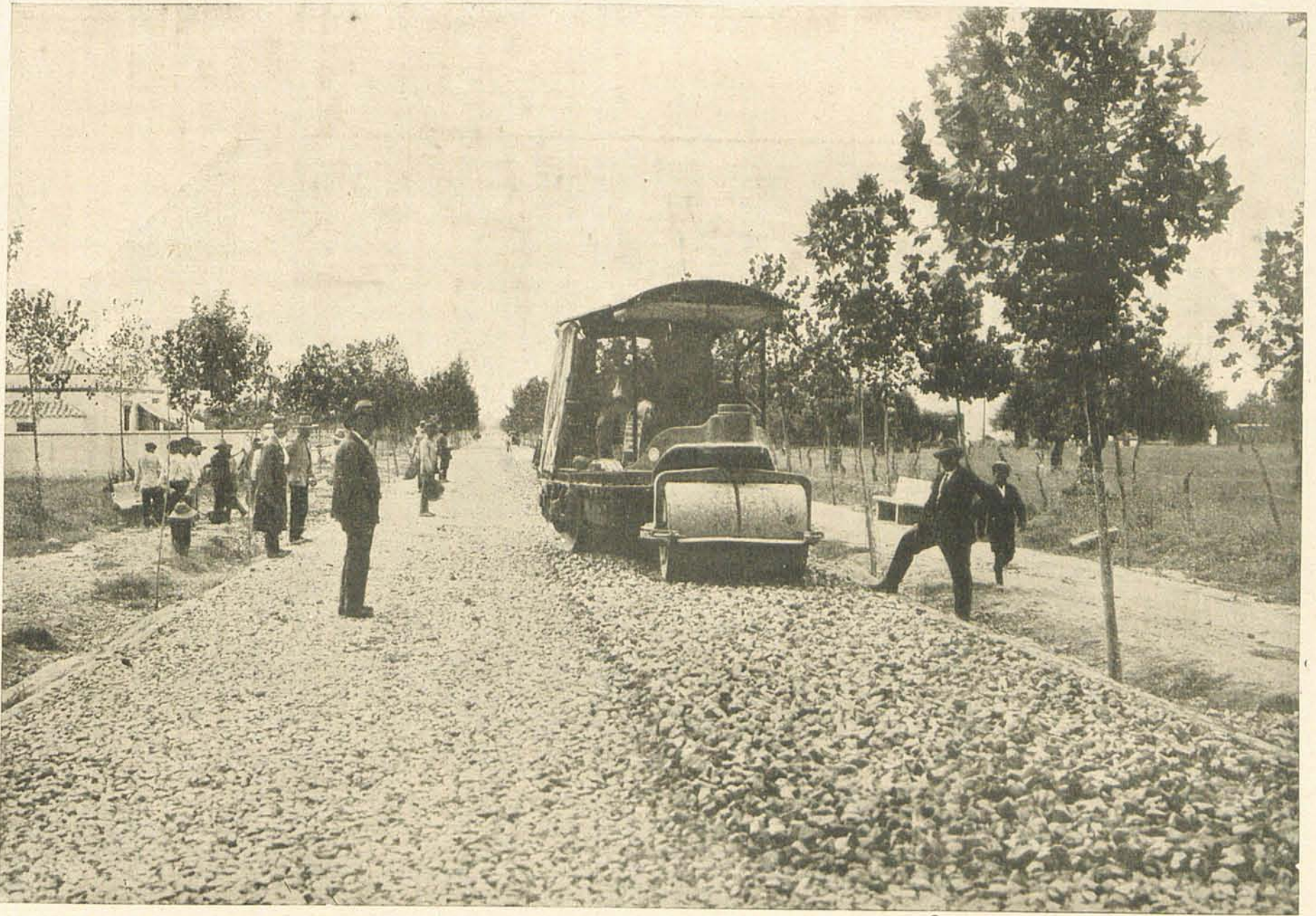
Sevilla.—Hormigón asfáltico. Preparación del firme
