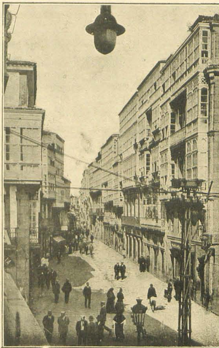
LA CORUÑA.—Calle Real.
