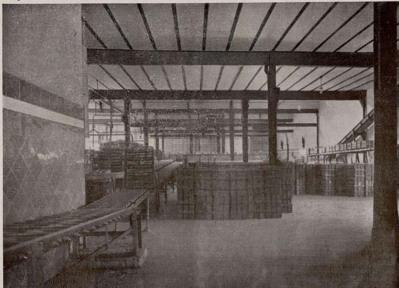
Almacén de la fábrica de cervezas EL AGUILA, pavimentado con loseta de asfalto comprimido C. P. A.
