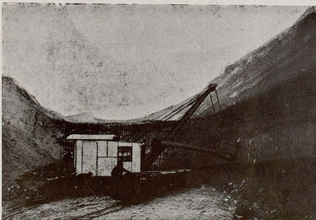
Excavando tierras para la fabricación de cementos.
