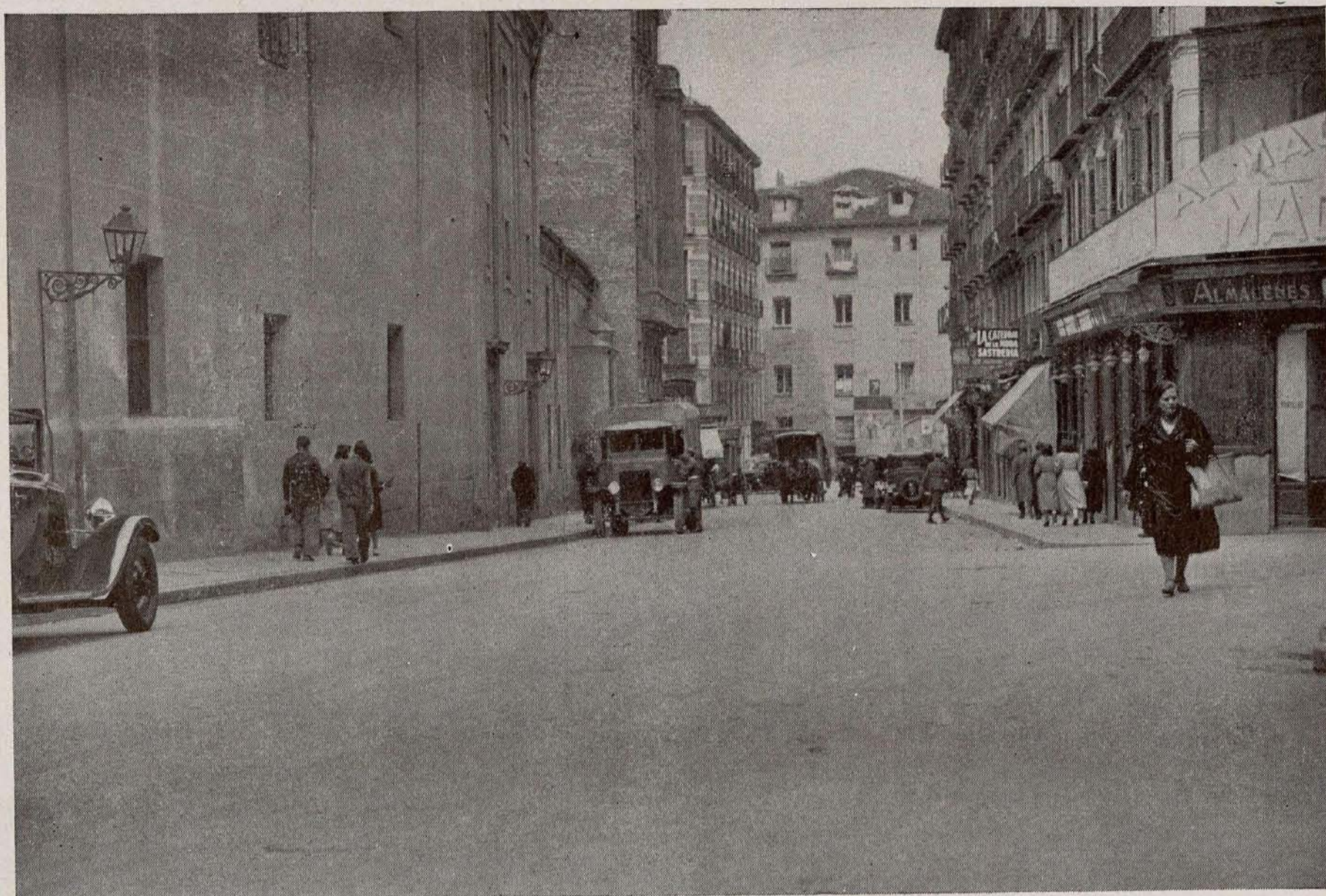
Calle de la Colegiata, pavimentada con losetas de asfalto C. P. A., en Madrid.
