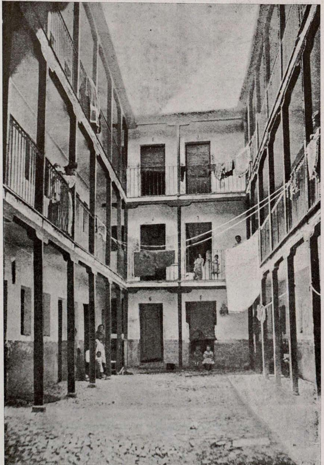
Interior de una casa de vecindad de la calle de Ercilla, de Madrid.
