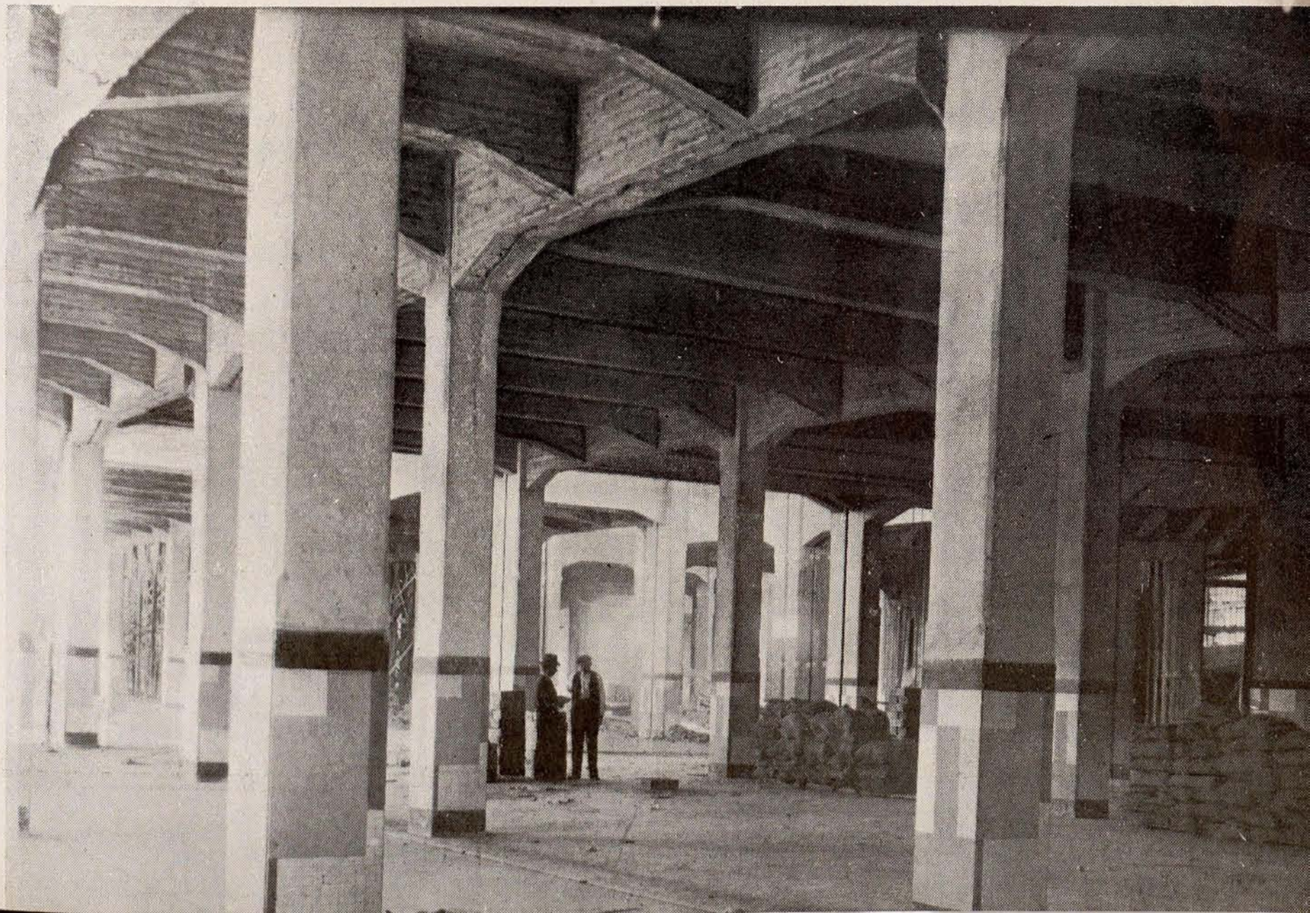
Nave del nuevo mercado central de pescado, en construcción en Madrid, en el final de la calle de la Arganzuela (Latina).
