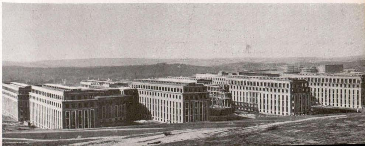
Facultad de Medicina, en construcción, vista por su fachada posterior. Al fondo, la Facultad de Filosofía y Letras, y en la lejanía, El Pardo y la Sierra castellana.
