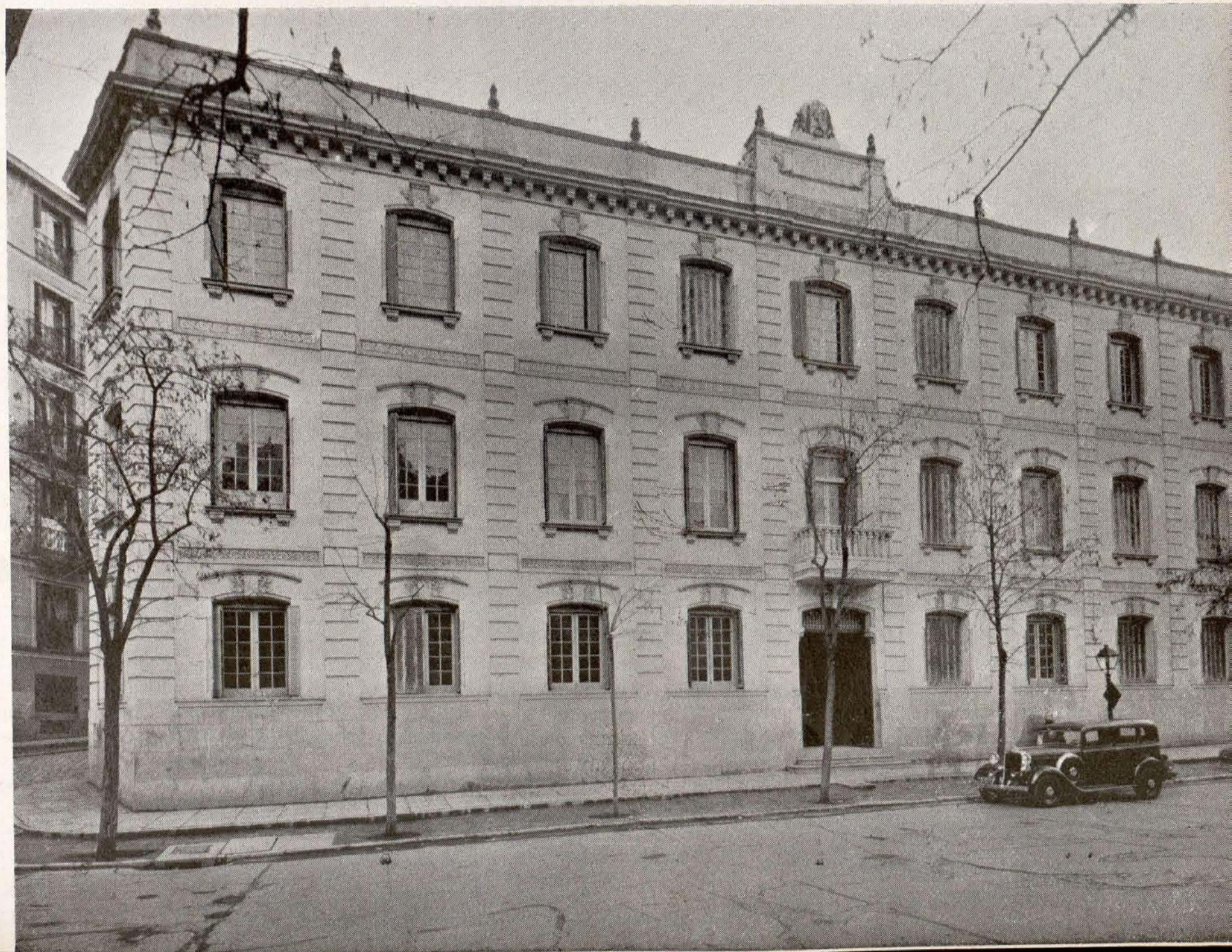
Fachada del Laboratorio Municipal de Higiene, después de las obras de ampliación que se han hecho recientemente para dotarle de todos los servicios.
