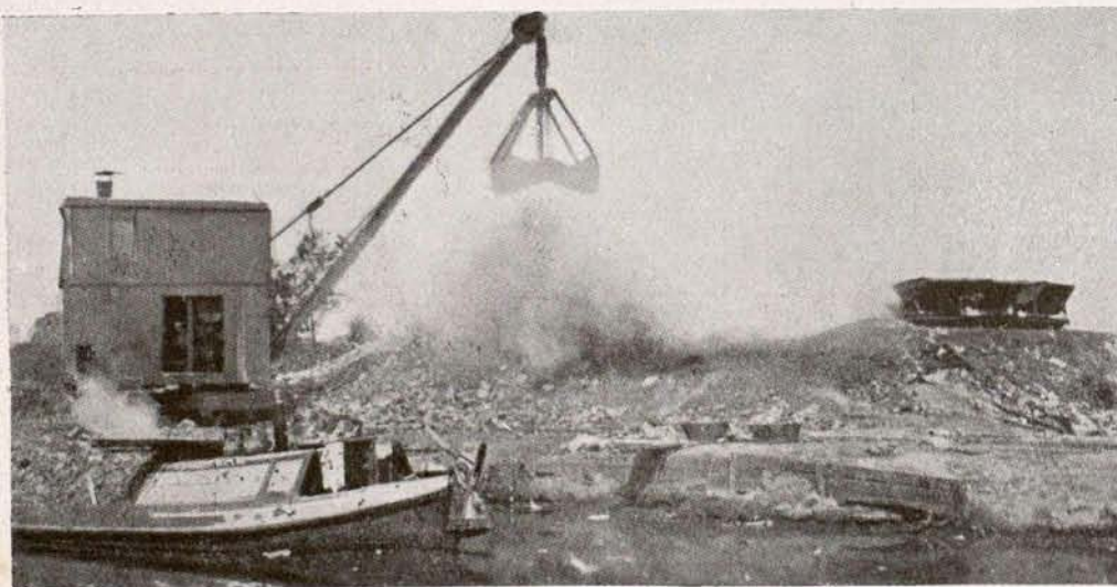
Descarga de basuras de barco a vertedero (Londres).
