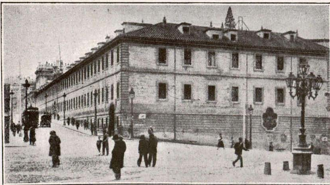
El antiguo edificio de Caballerizas, derribado actualmente.
