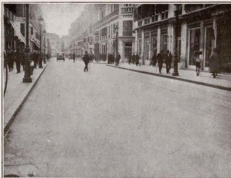
*Calle del Marqués de Larios, en MÁLAGA, pavimentada con loseta de asfalto C. P. A. en el año 1909.*
