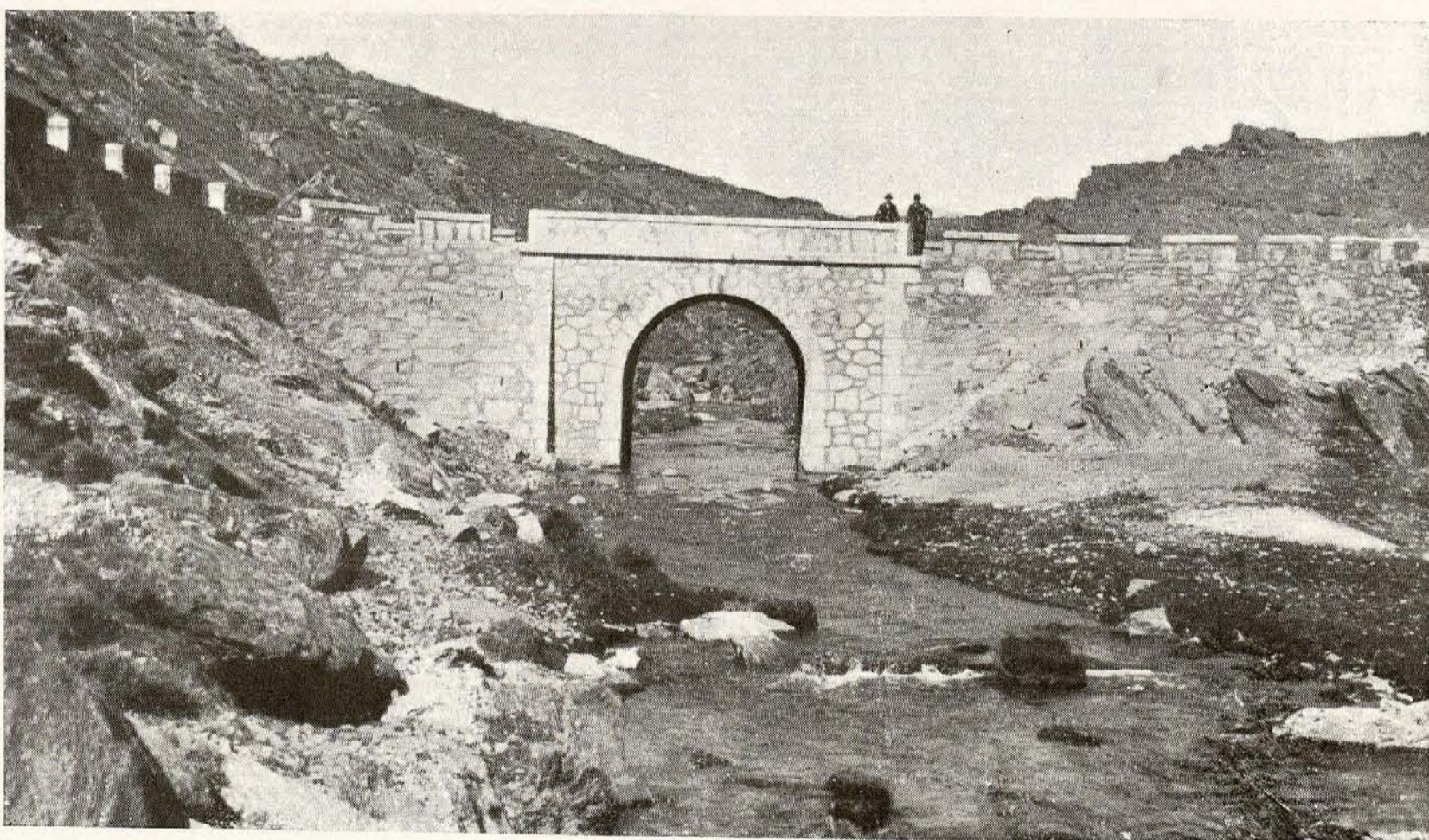
Vías y Obras Provinciales. —Puente en el camino de la carretera general de Francia a Montejo de la Sierra.
