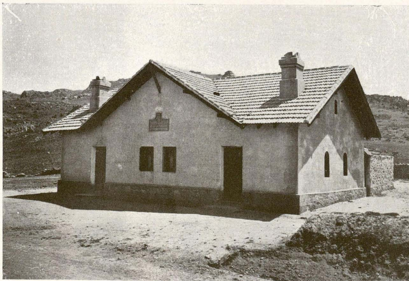
Vías y Obras Provinciales. —Casilla de peones camineros en el camino de Colmenar Viejo a Guadalix.
