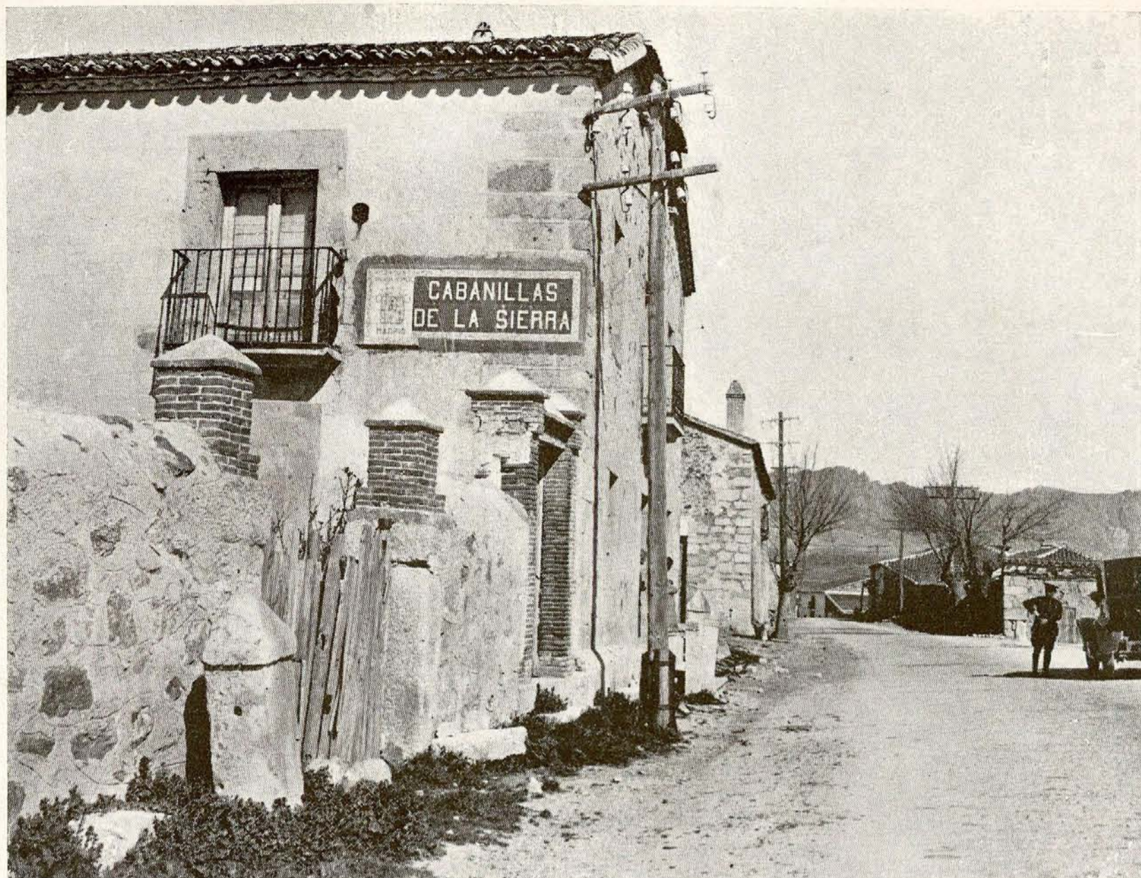
Vías y Obras Provinciales. —Modelo de rotulación de pueblos, en azulejos, letra blanca sobre fondo azul, colocada en todas las entradas de caminos y carreteras.
