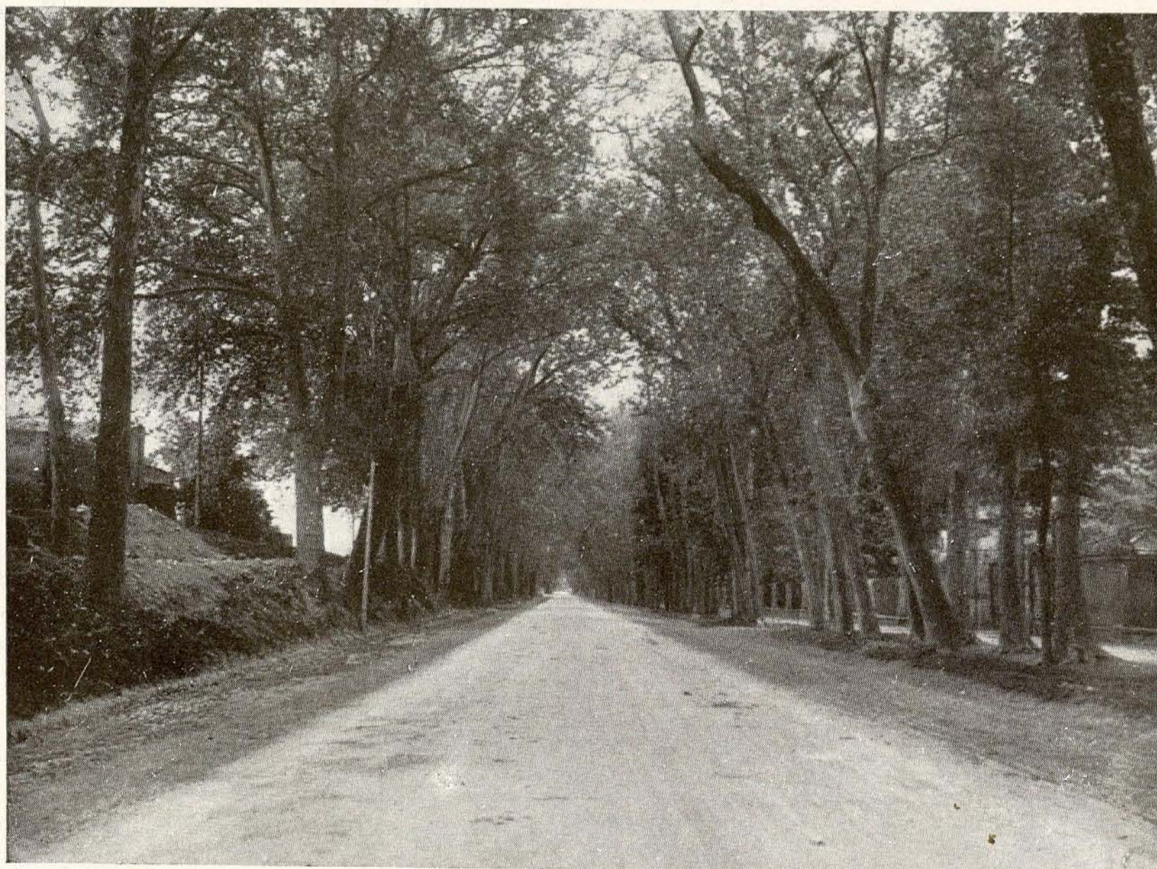
Servicios forestales. —Calle de la Reina en Aranjuez, carretera provincial de Aranjuez a Brea de Tajo, firme de hormigón asfáltico.
