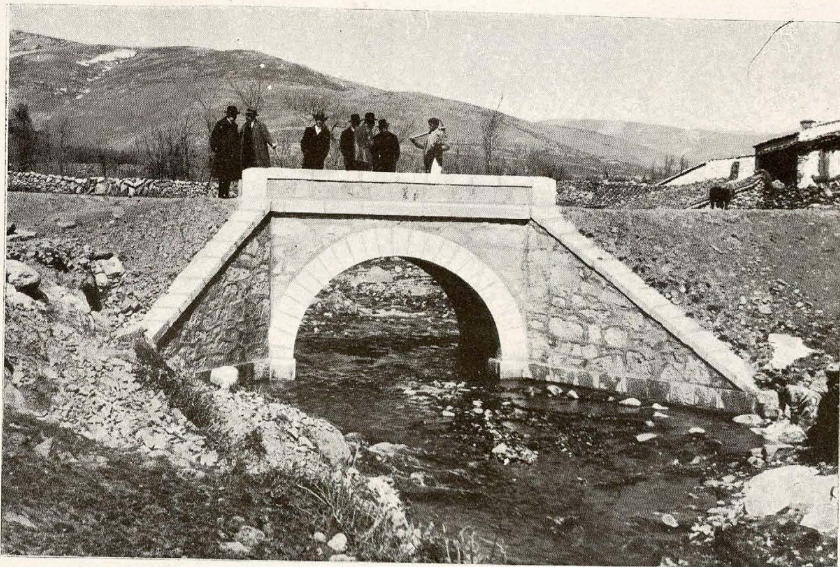
Vías y Obras Provinciales. —Pontón en el camino provincial de San Mamés.
