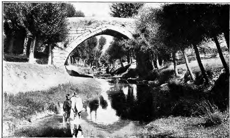
BRIVIESCA.— PUENTE ROMANO
