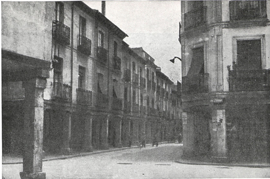
Una de las calles de Alcalá de Henares.
