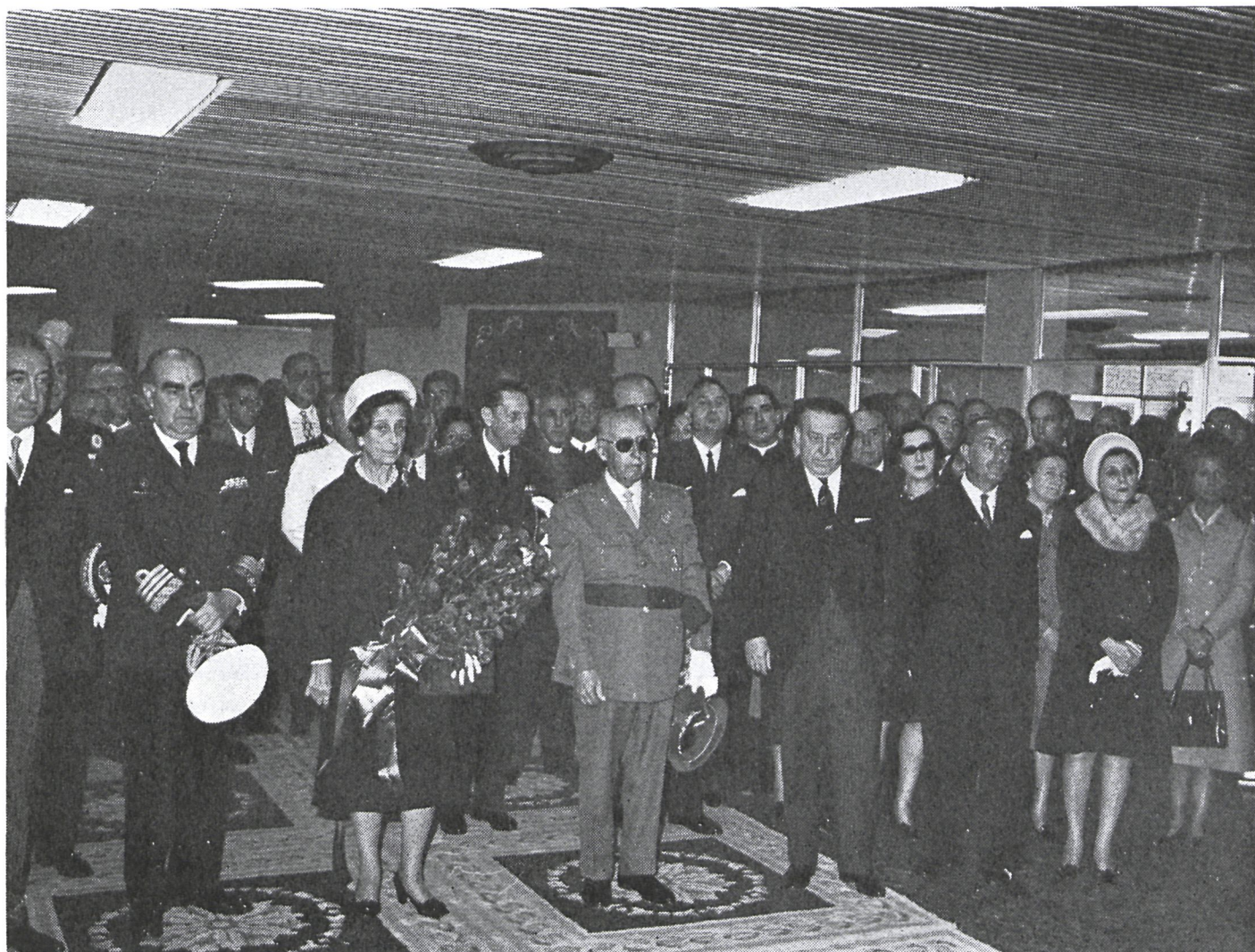
Un aspecto de la presidencia del acto, mientras el Arzobispo de Madrid-Alcalá, Dr. Morcillo, revestido de pontifical, bendecía las instalaciones.
