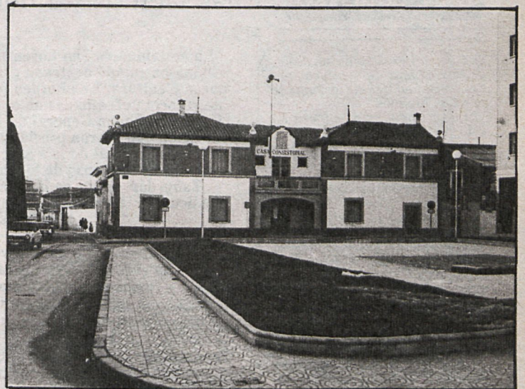
La Casa Consistorial de Mejorada del Campo se ha quedado pequeña, y los 25 millones ofertados permitirían edificar unas nuevas instalaciones
