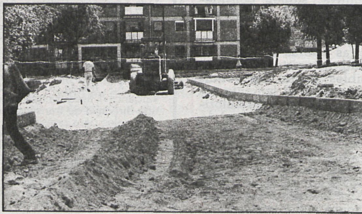
Las obras son el otro principal causante de que los responsables municipales no se muevan de su sitio
