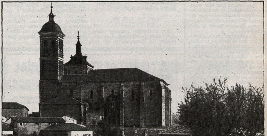
La iglesia de Nuestra Señora de la Asunción, de Meco, está pidiendo a gritos su reparación
