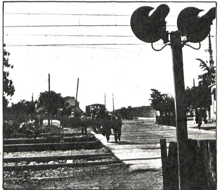
Uno de los pasos con mayor tráfico, el de la carretera de Loeches, que da paso a la zona industrial y a una zona de viviendas que aglutina a más de 80.000 habitantes
