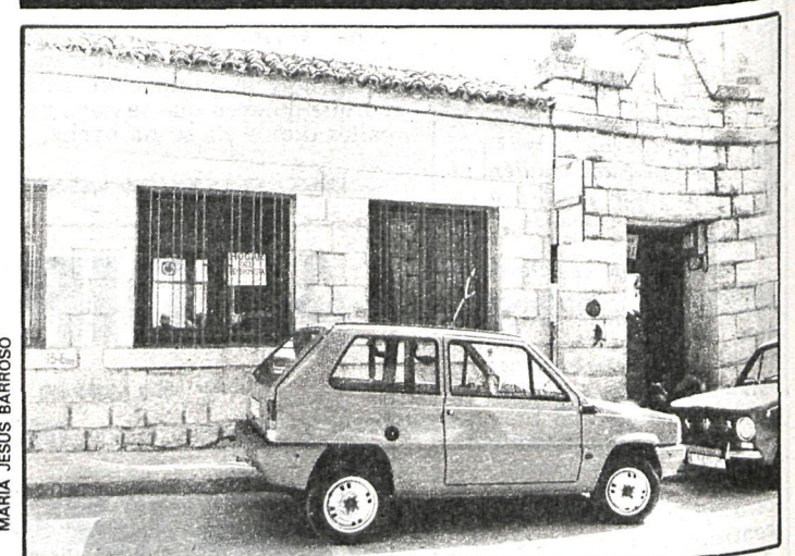
Este es el edificio acondicionado para albergar el Hogar del Pensionista
