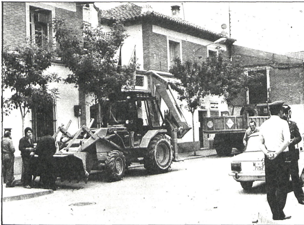
La máquina excavadora, que el día señalado no pudo actuar
