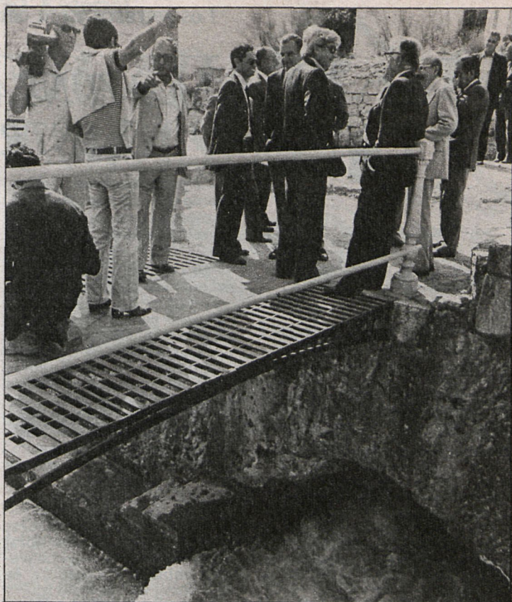
César Cimadevilla, consejero de Obras Públicas de la Comunidad de Madrid, y Rodolfo Urbistondo, director del Canal de Isabel II, acompañados de técnicos de sus respectivos departamentos, inauguraron las obras de reacondicionamiento del Canal de la Parra, sobre cuyo caudal de salida, aforado en tres metros cúbicos por segundo, se les ve en esta fotografía
