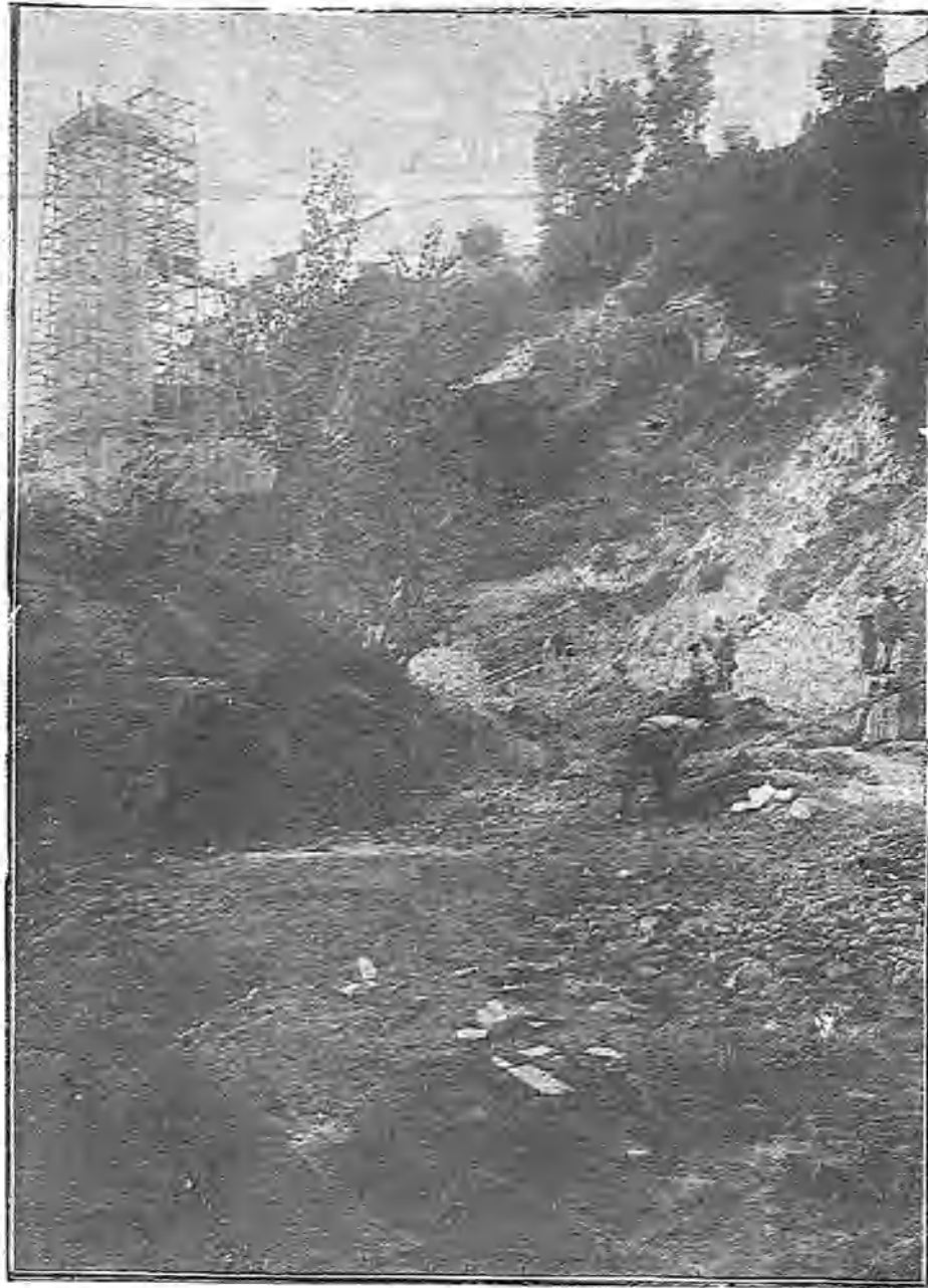
CONSTRUCCION DEL PUENTE DE CANALEJAS SOBRE EL SERPIS
