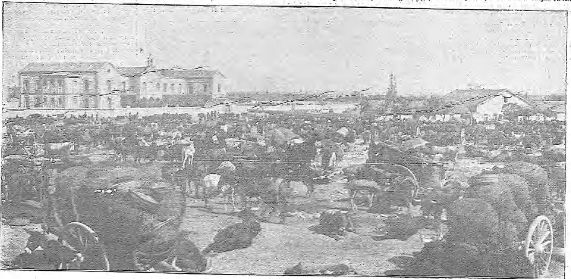
VISTA PANORAMICA DEL RODEO, DONDE SE ENCUENTRA INSTALADA LA FERIA DE GANADOS
