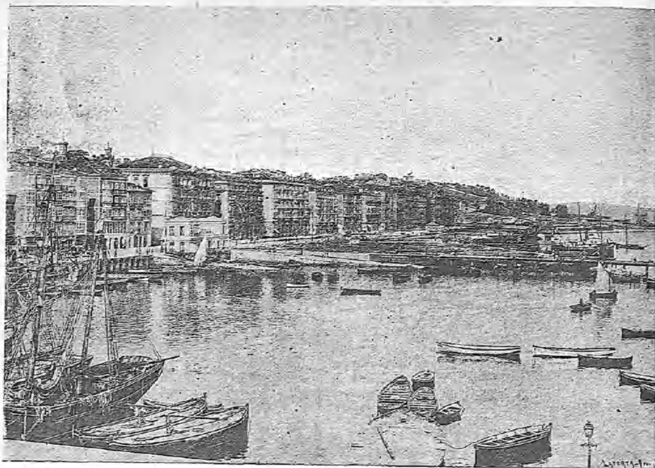
VISTA GENERAL DEL MUELLE DONDE OCURRIÓ EL 3 DEL ACTUAL LA HORRIBLE CATÁSTROFE.
