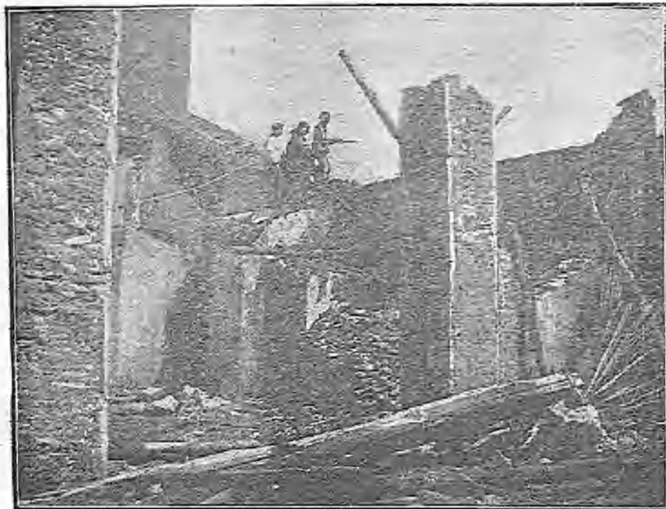
TALLERES DE SERRERÍA Y MOLINO HARINERO DESTRUIDOS POR EL INCENDIO
