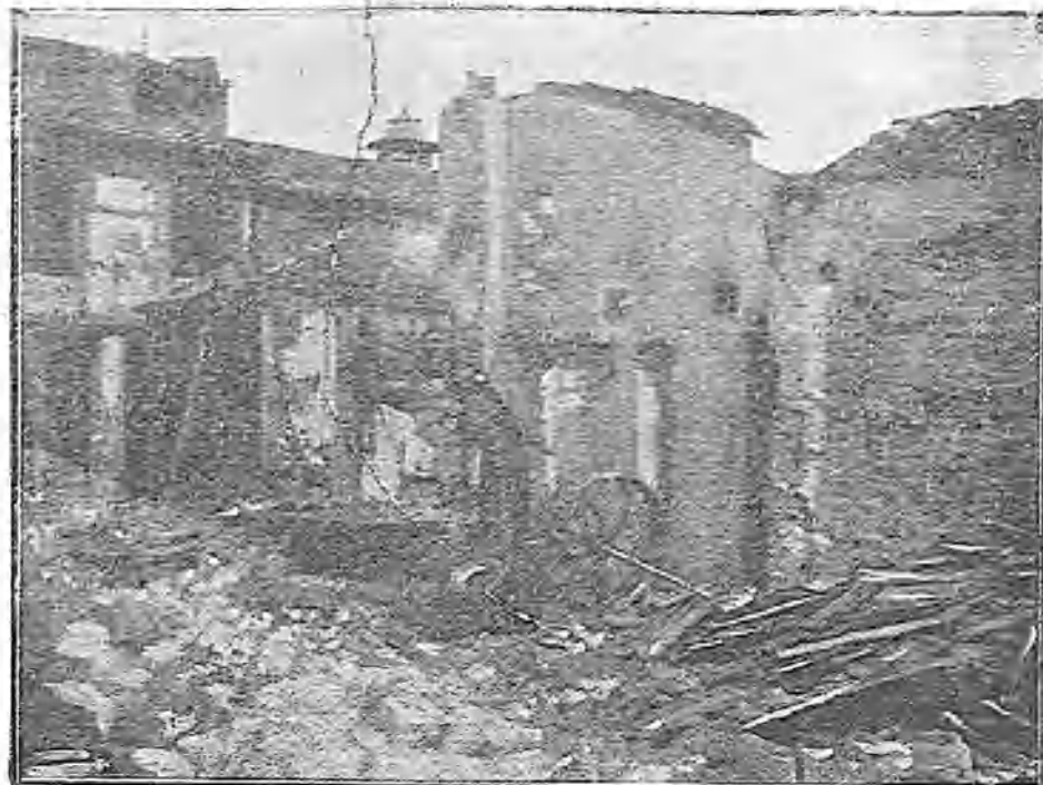
RUINAS DE LOS EDIFICIOS DESTRUIDOS POR EL INCENDIO
