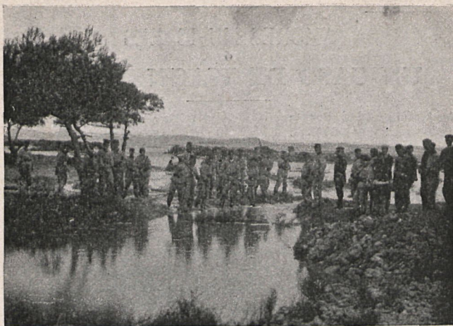
INUNDACIÓN DE CASTELLÓN Bomberos abriendo zanjas en el Pinar.
