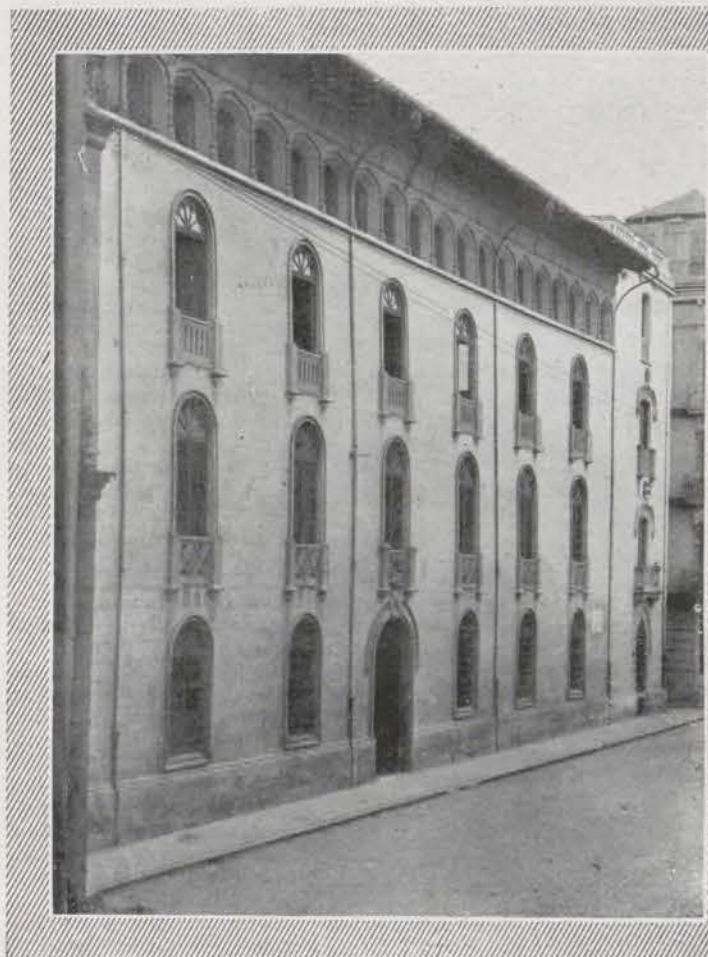
La fachada del palacio levantino de los Marqueses de Benicarló, muestra el buen gusto artístico de los distinguidos aristócratas.
