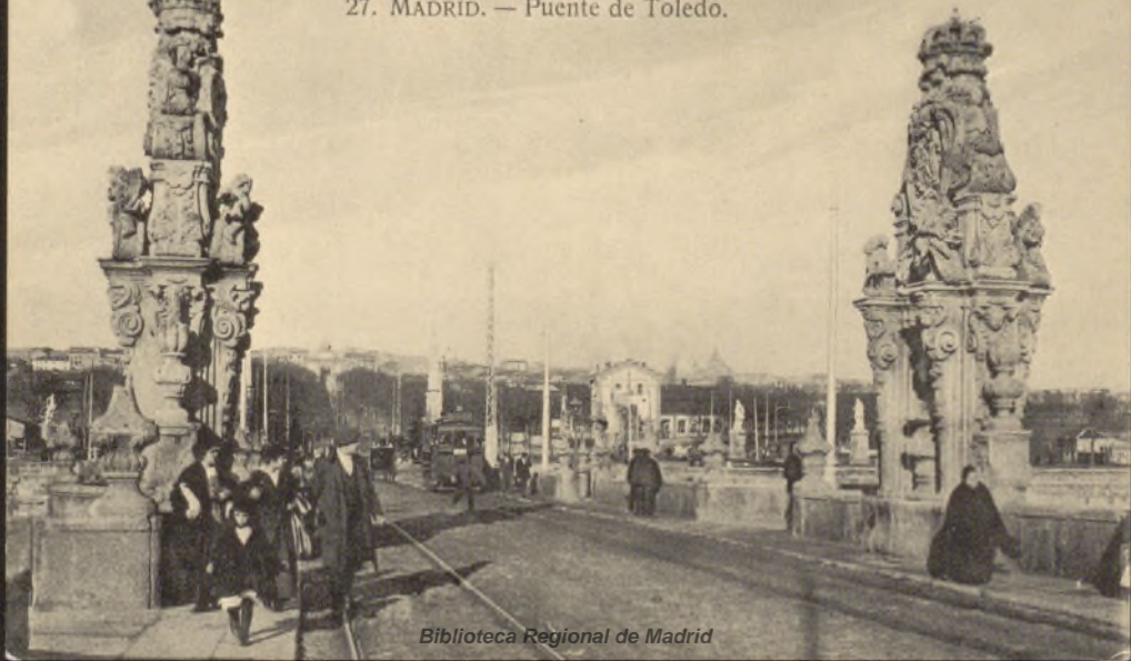
27. MADRID. — Puente de Toledo.
