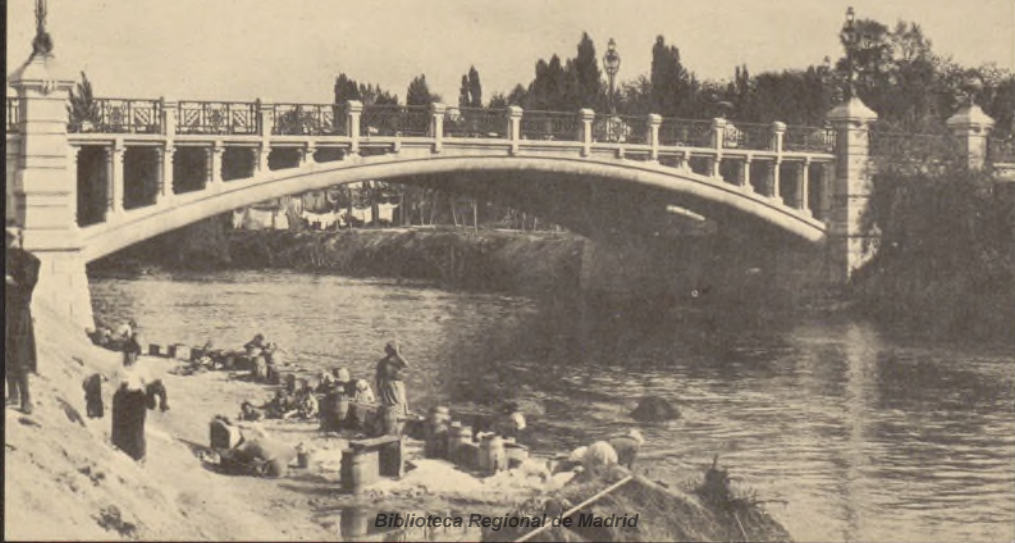
9 MADRID Puente Reina Victoria.
