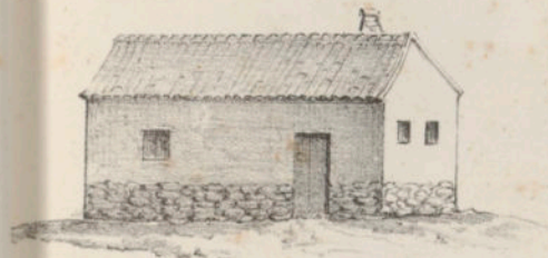
5 a Casilla de Guarda.
