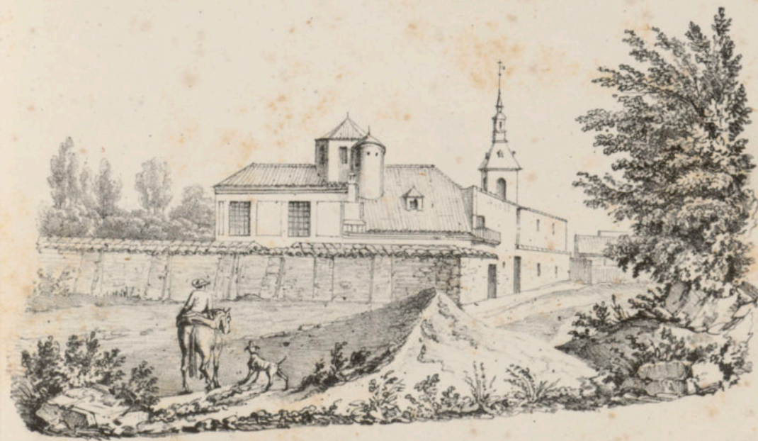
Casa de campo del repostero de S.M. en Villaverde.
