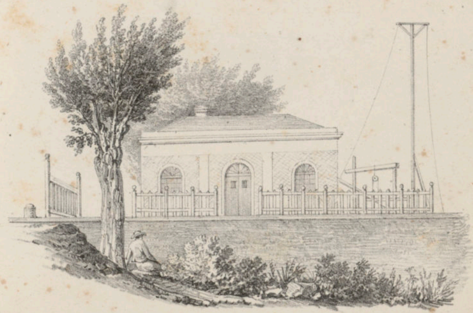
Casilla de Guarda, en el camino real.
