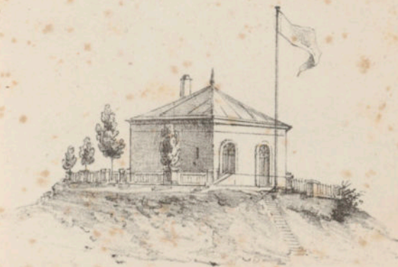
1ª Casilla de guarda.
