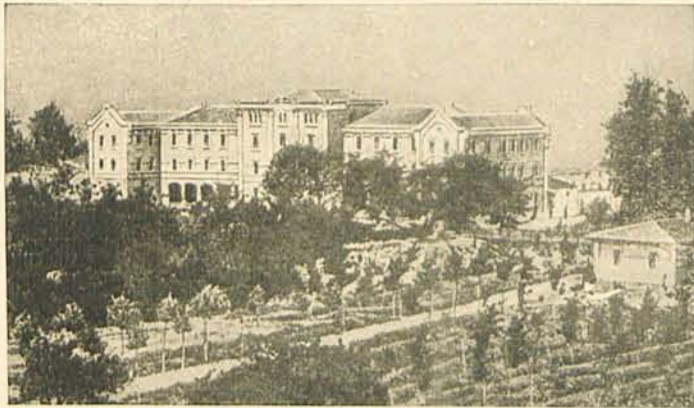
Balneario de Vallfogona.—Fachada
