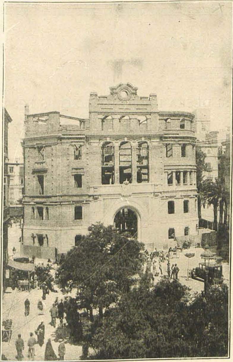
Cádiz.—Casa de Correos y Telégrafos.
