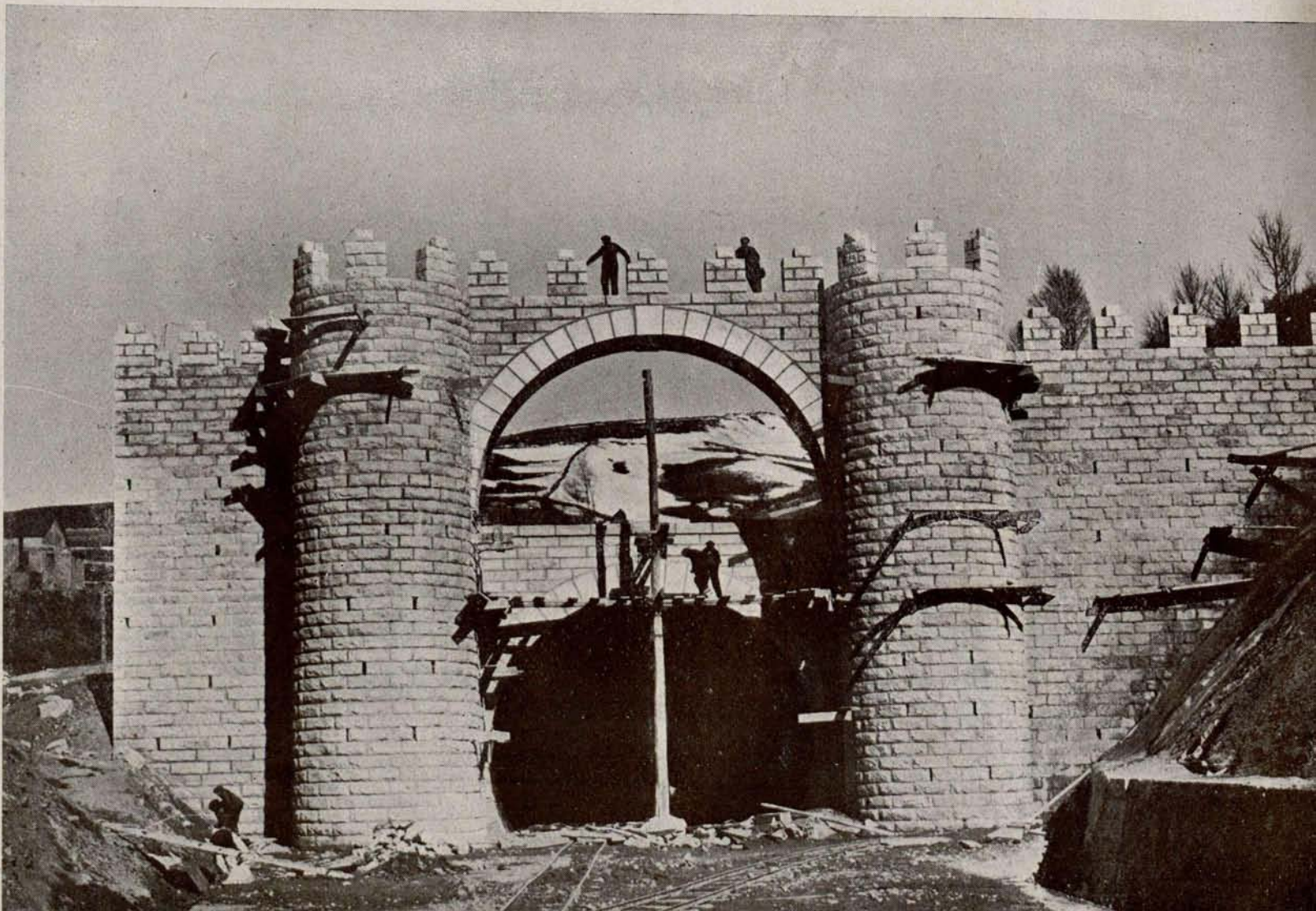
Túnel de Somosierra: Boquilla sur. (Entrada.)
