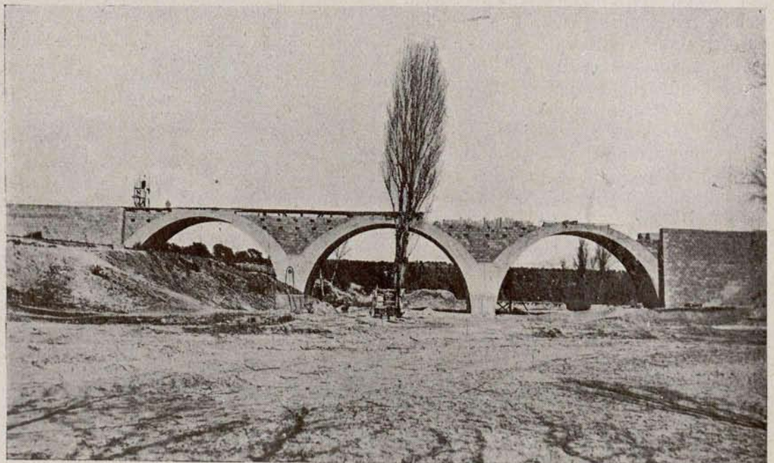
Puente sobre El Arenalón, en la línea de Fuencarral a las Matas.
