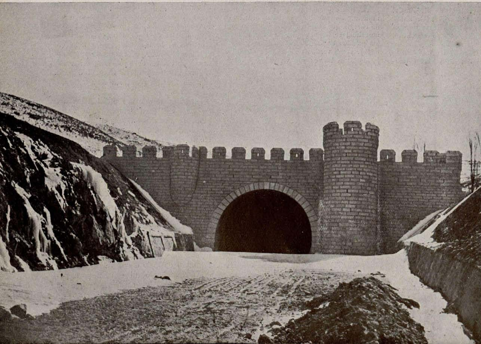
Túnel de Somosierra: Boquilla norte. (Salida.)
