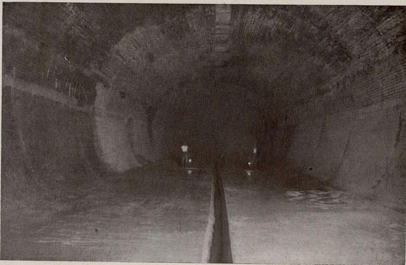
El túnel, completamente terminado.
