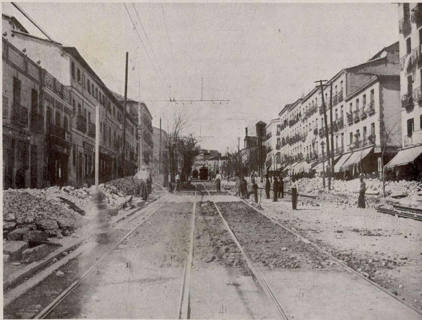
Estado actual de las obras del paseo de Extremadura.
