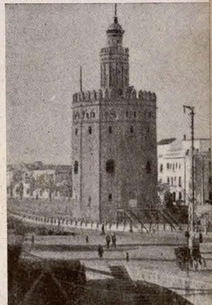
Sevilla: Torre del Oro.
