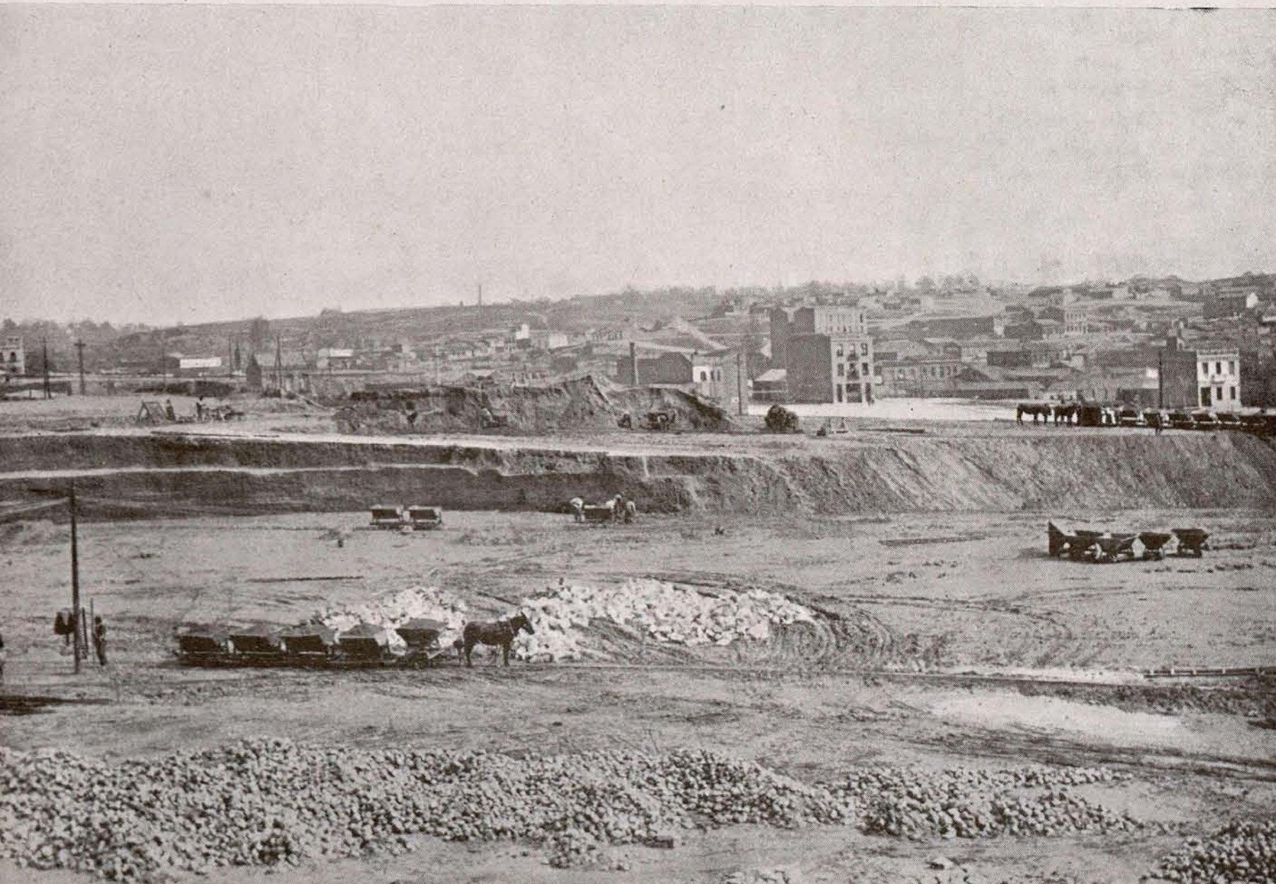
Obras de accesos a la Nueva Plaza de Toros. Gracias a la actividad socialista municipal en estas obras, ya muy avanzadas, han encontrado ocupación varios cientos de obreros.
