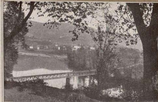
Puente de hierro sobre el Nervión
