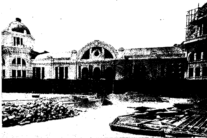
MADRID.—Ampliación y mejora de la Estación del Norte. Vista de la fachada principal del nuevo edificio.
