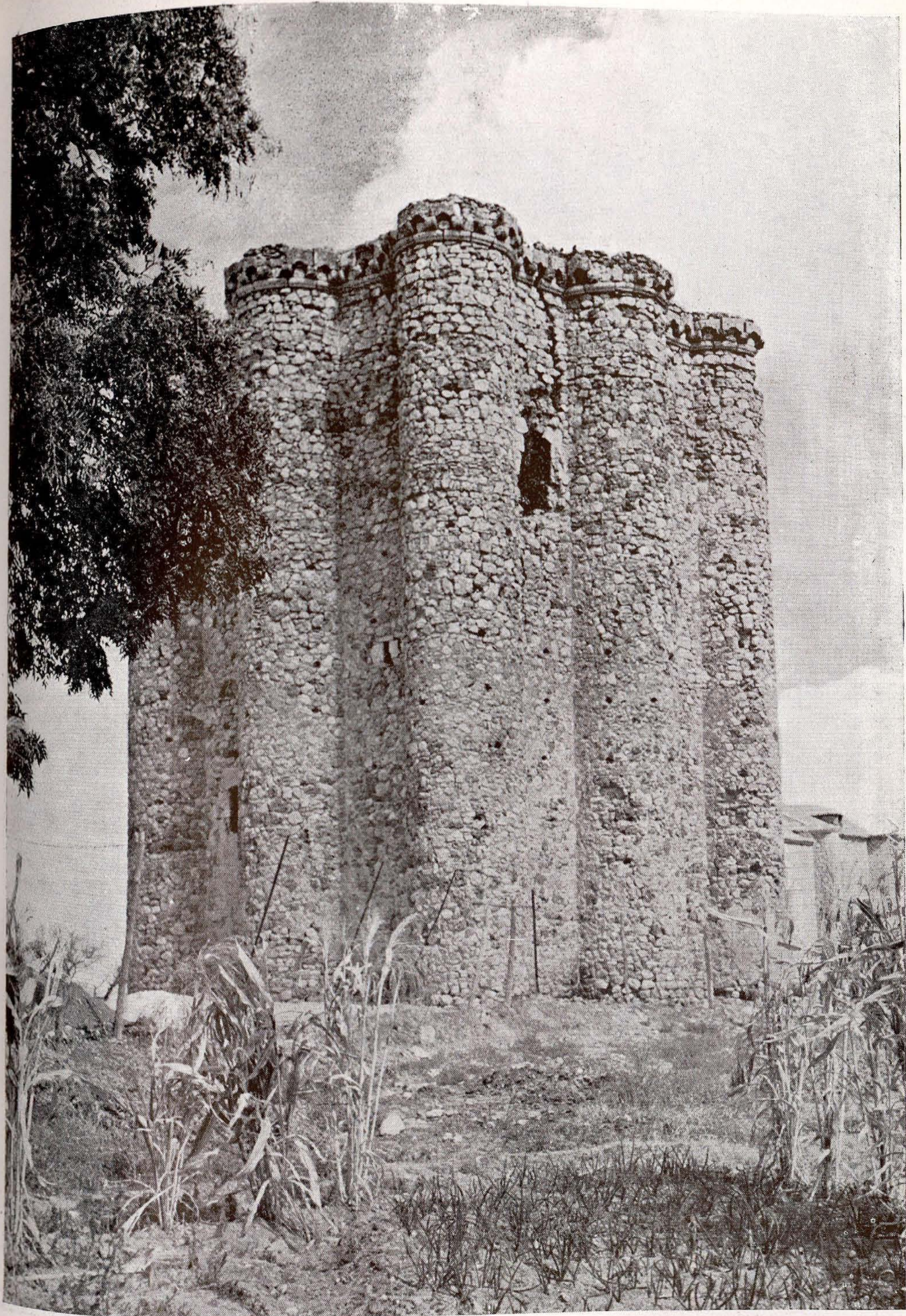
El torreón de Villarejo de Salvanés (Foto Loygorri.)
