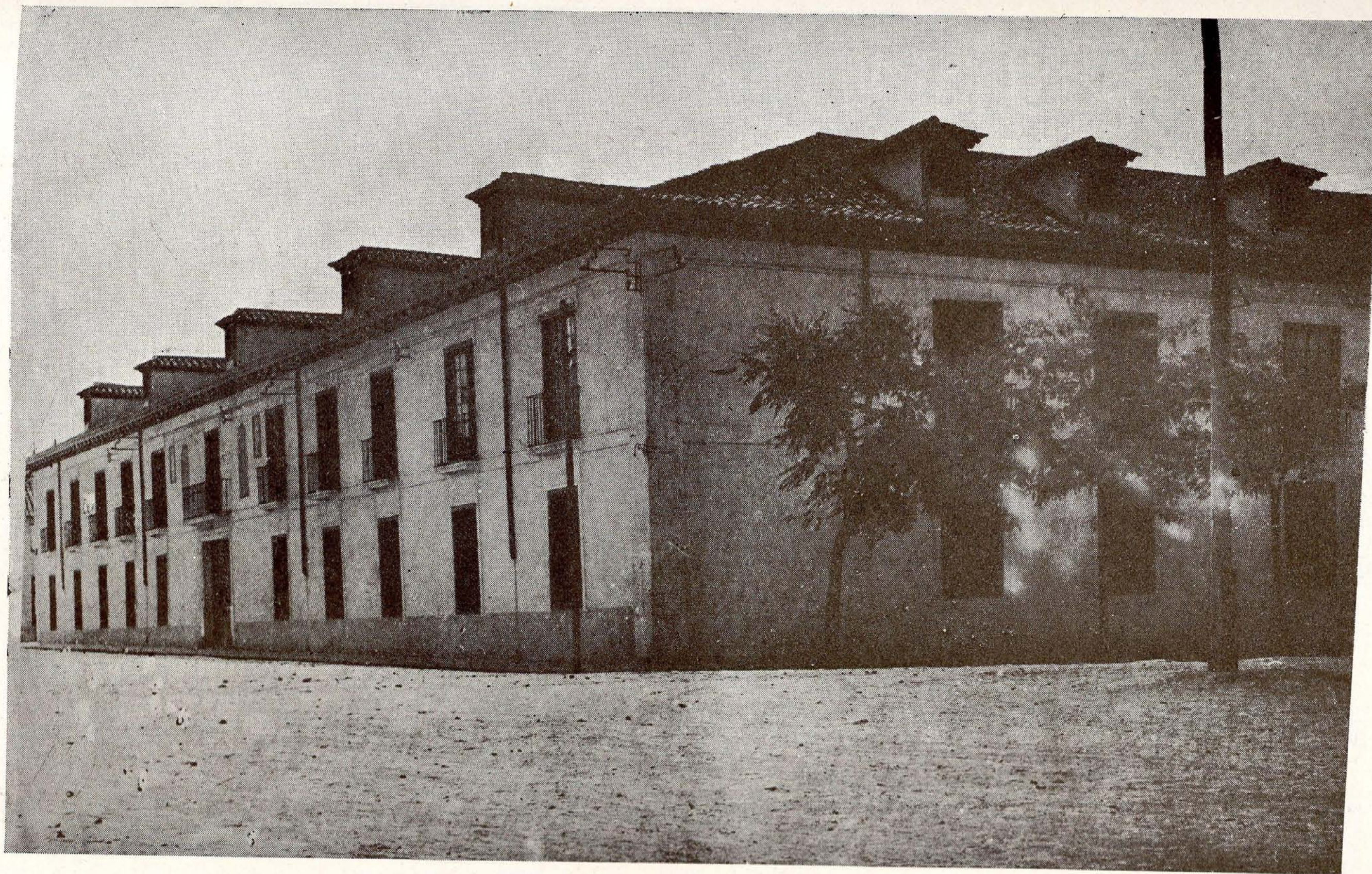
Residencia de Ancianos de San Isidro Labrador, en Aranjuez.—Fachada principal.
