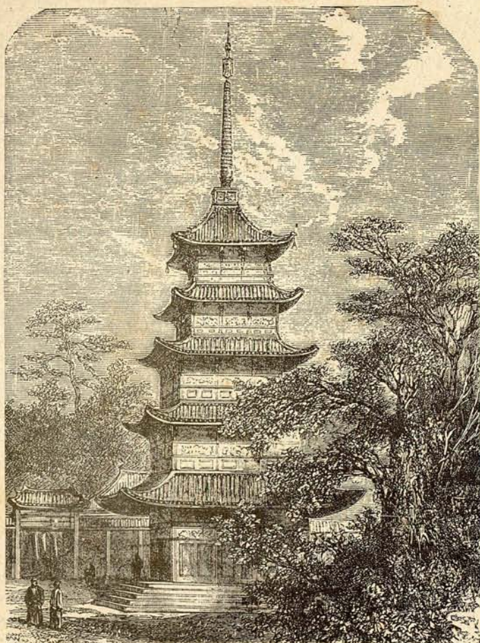
OASAKA.—TORRE DE LA PAGODA TENGIS
