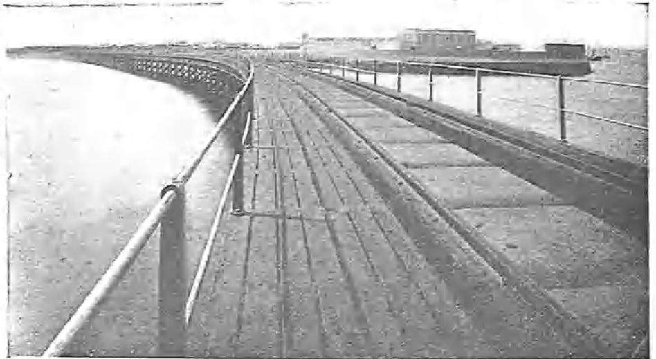
Puente de Puntales.
