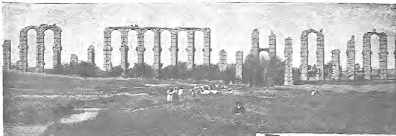
MÉRIDA.—Ruinas del acueducto.
