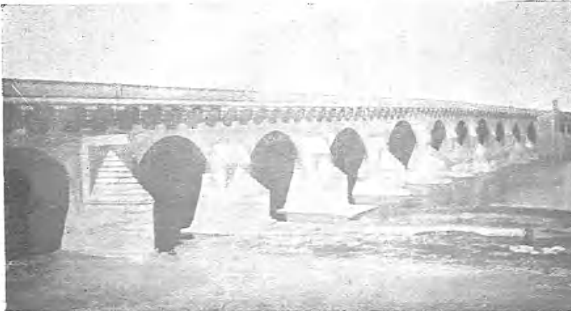
BADAJOZ.—El puente sobre el Guadiana.
