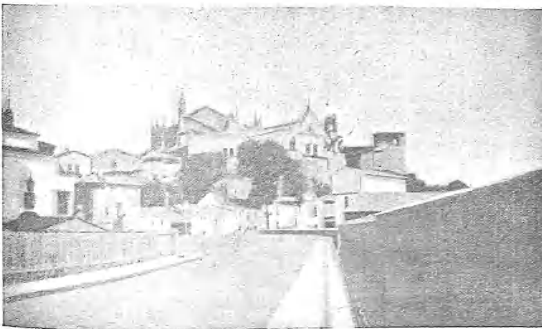
Vista de Plasencia desde el puente.
