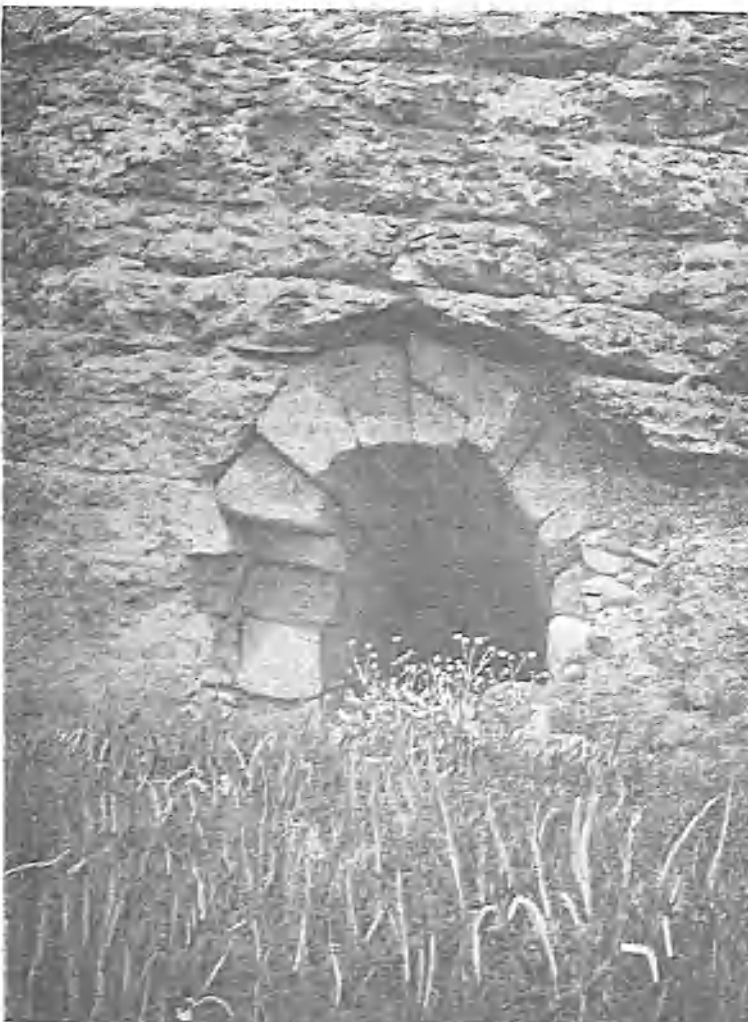
Una de las puertas de vomitorium del anfiteatro.
