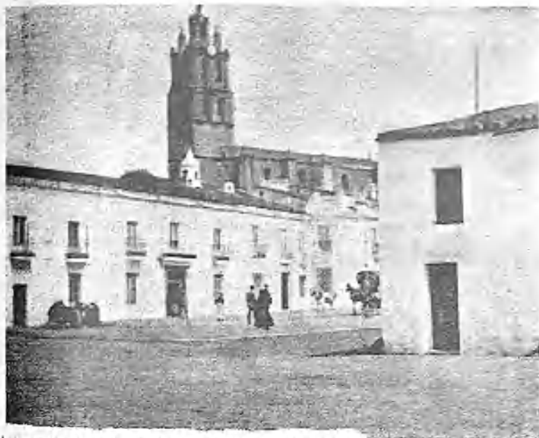
ALMEDRALES.—Un rincón de la plaza y torre de la iglesia.
