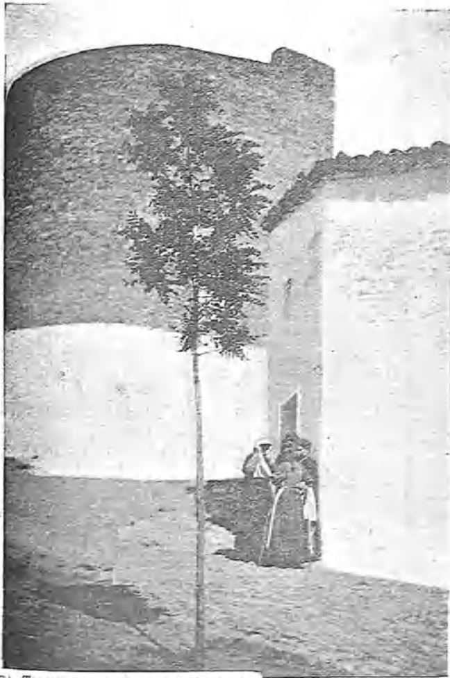
ZAFRA. Torreón de entrada á la calle de Tetuán.
