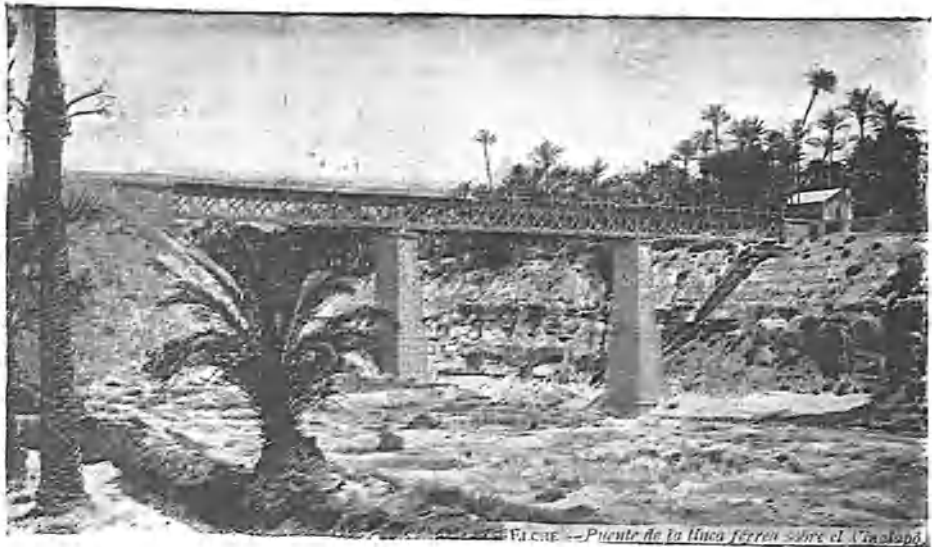
Elche. — Puente de la Illice férrea sobre el Vinalapó.
