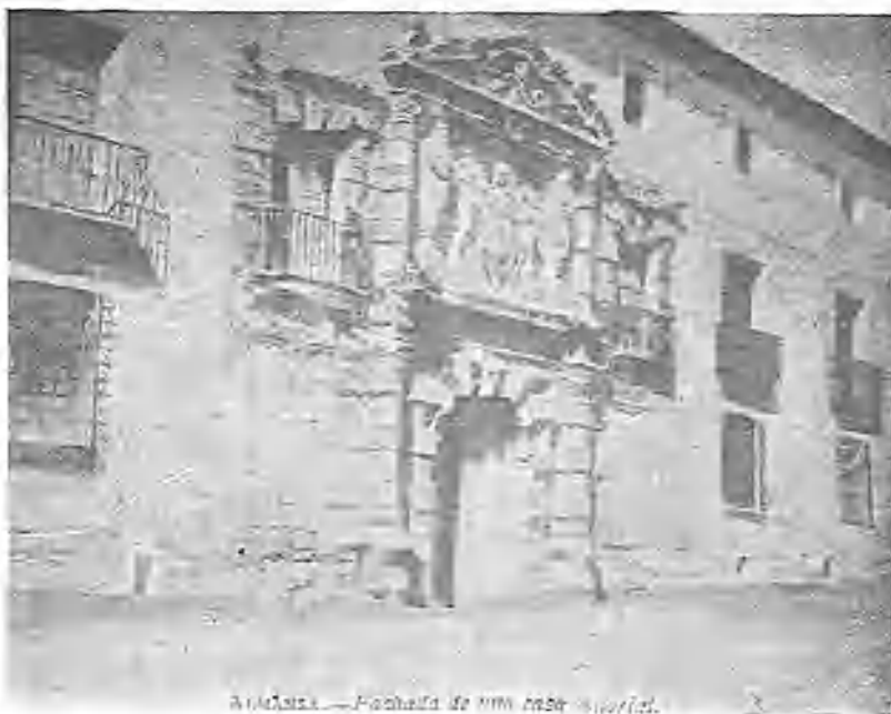
ALMANSA.—Fachada de una casa antigua.
