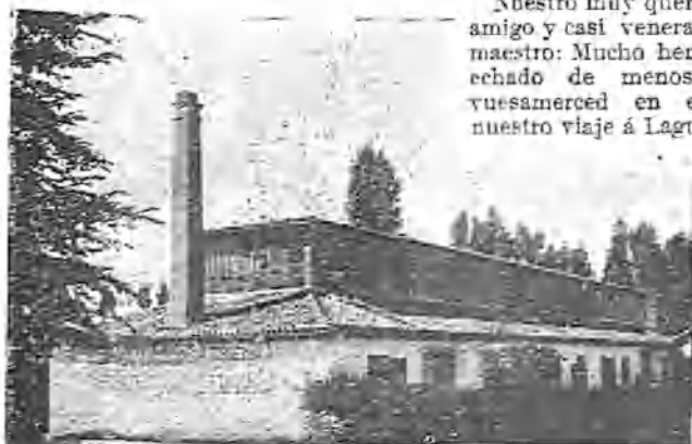
QUINTANILLA.—Fábrica de máquinas, terminadas, de Quintanilla.
