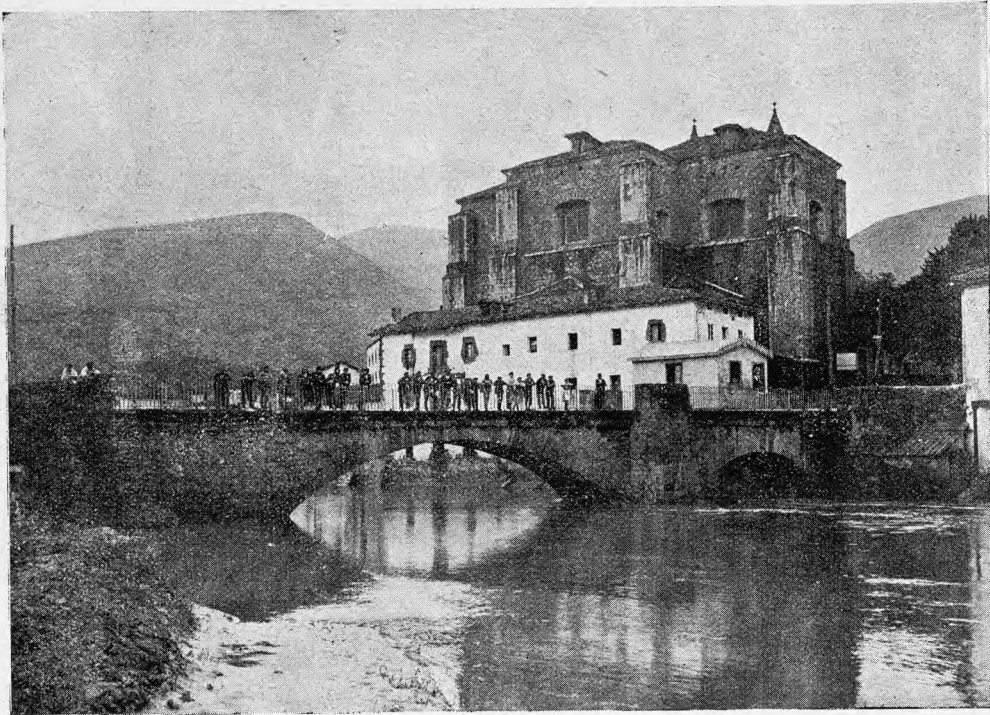
Puente en San Juan de Somorrostro
