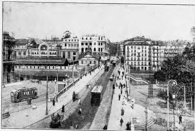
PUENTE DEL ARENAL
