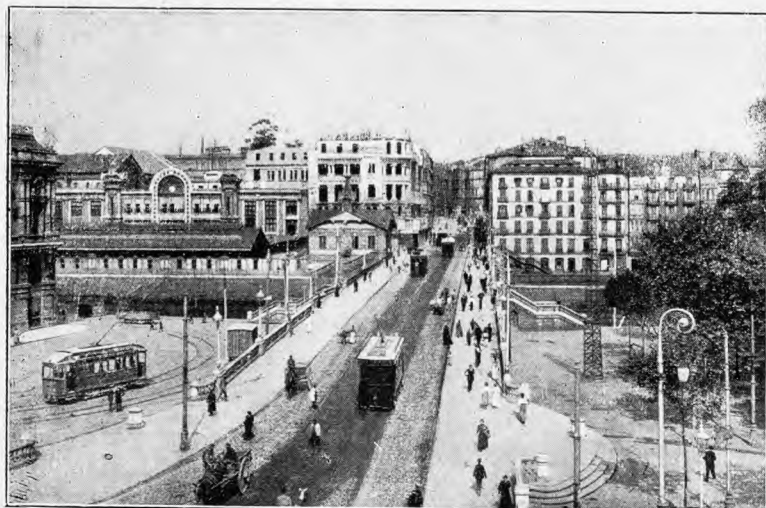
PUENTE DEL ARENAL
