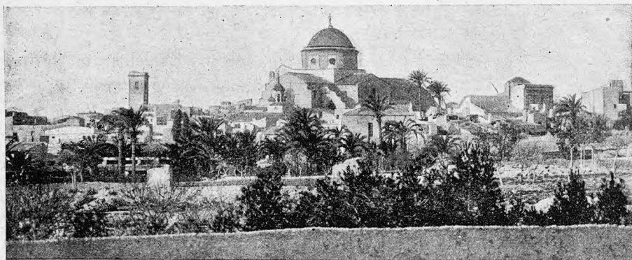
Crevillente. — Vista general
